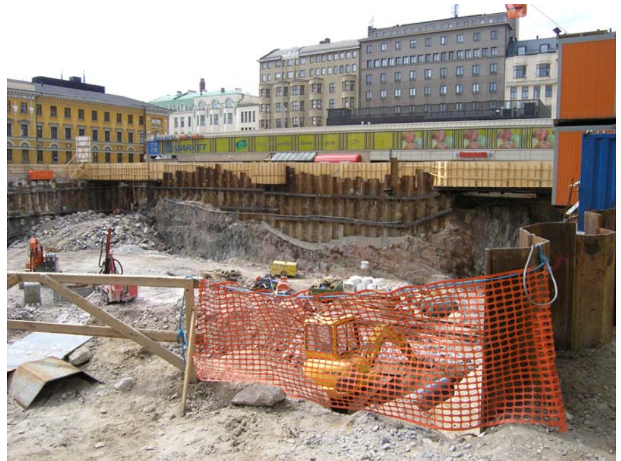
Helsingin Kasarmitorin pysäköintilaitos (töiden kesto: 11/2003 – n. 9-10/2005)
